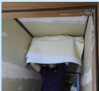
クロス張替えはトイレ空間と同じ条件で実習します。
