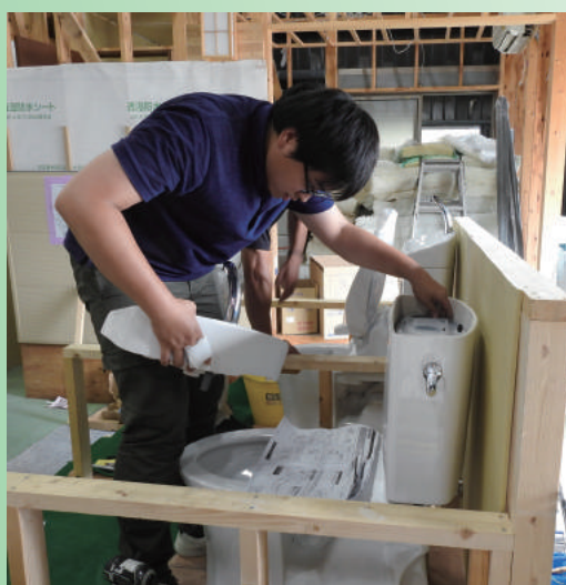
便器の設置、設置、撤去を繰り返していきます。
